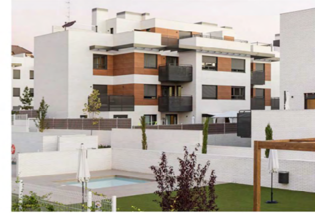
121 viviendas V.L. Boadilla del Monte Madrid
